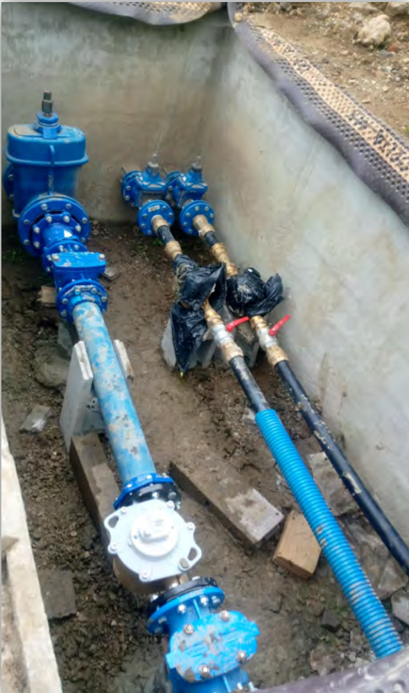
Branchement rue Vénizélos à Montigny-lès-Metz
