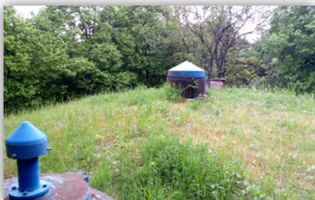
Têtes de puits des sources
