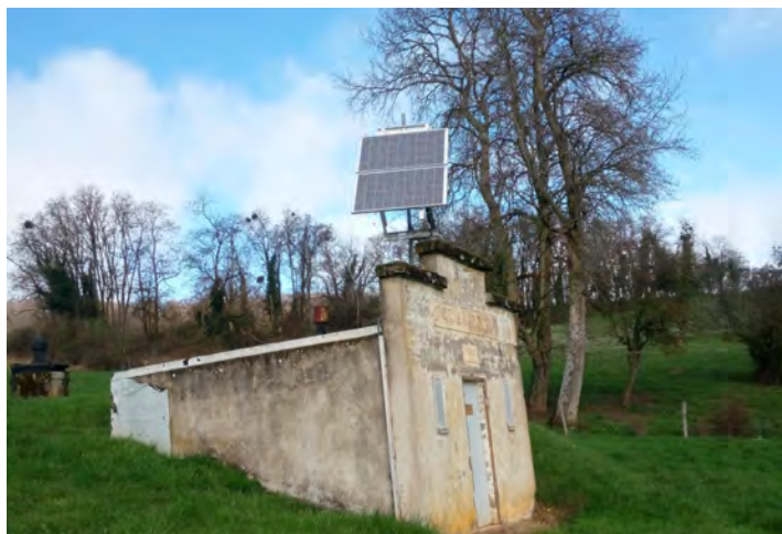
Réservoir de Mardigny
