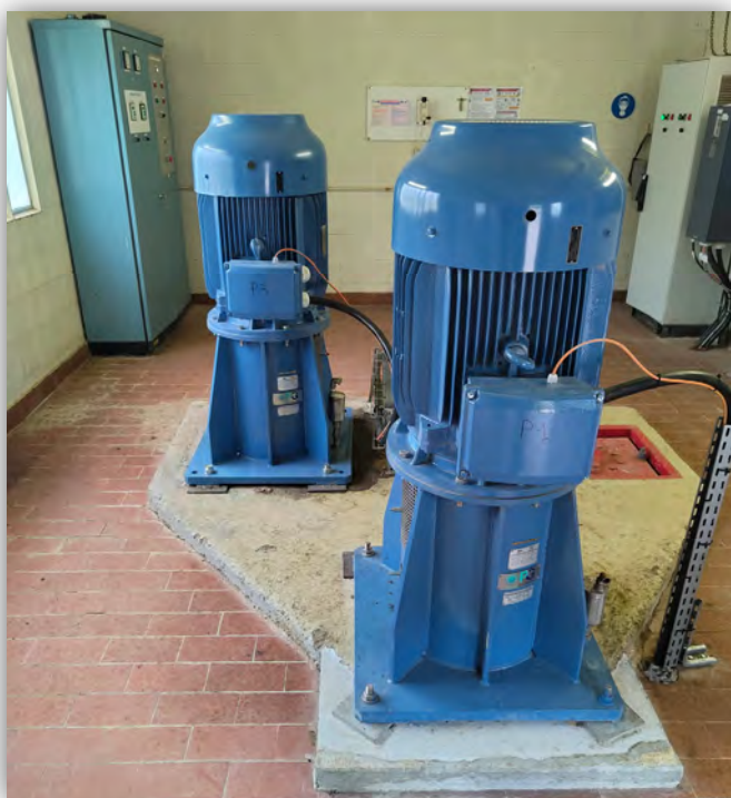
Renouvellement des pompes 1 et 3- Station de Châtel
