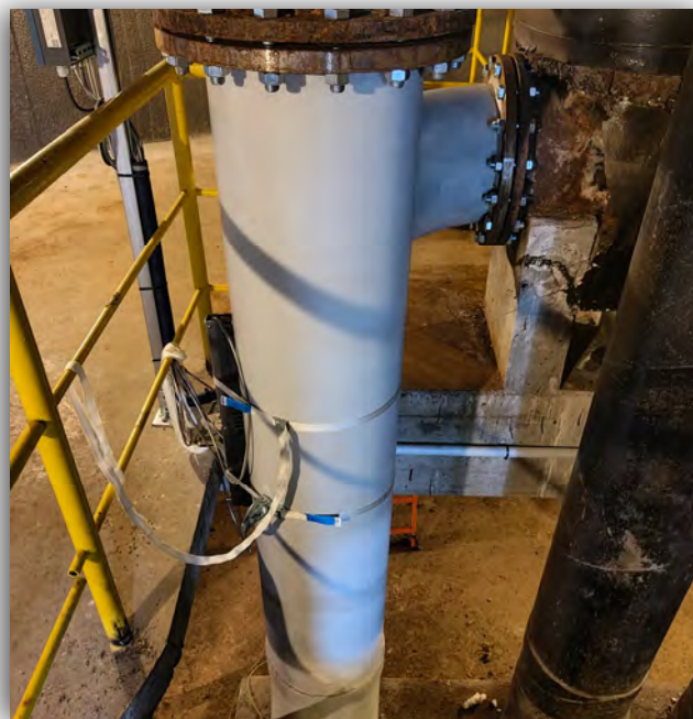
Renouvellement conduite - réservoir Grange-le-Mercier
