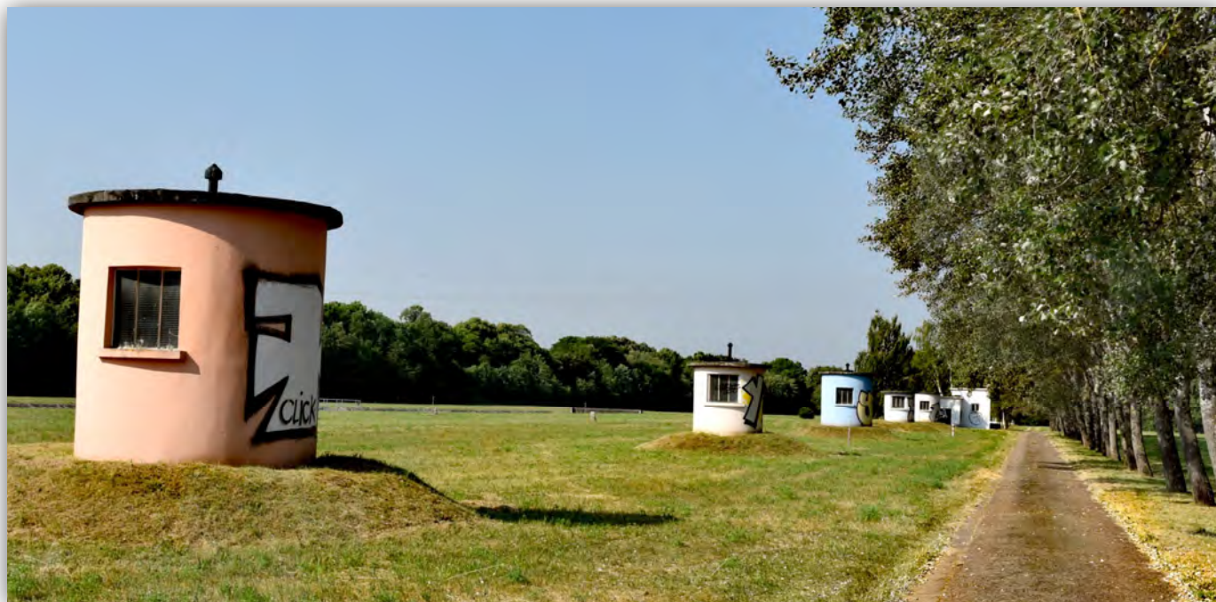
Puits - Site de Maison Rouge à Moulins-lès-Metz
