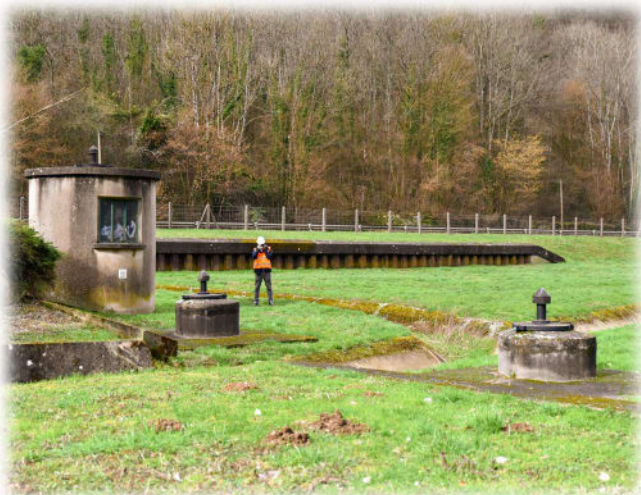
Exhaures de la station de reprise de Montvaux
