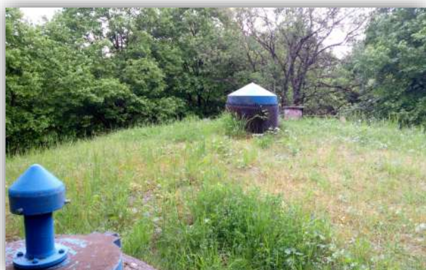
Têtes de puits des sources
