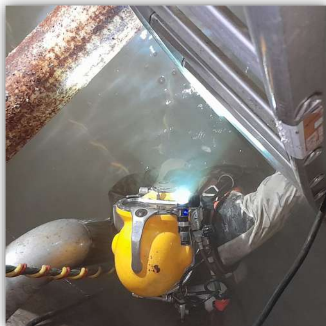
Renouvellement des vannes d'isolement - Bâche la Sablière
