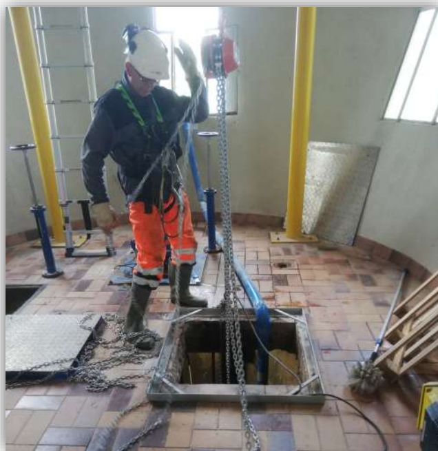
Renouvellement pompe 1 - La Sablière
