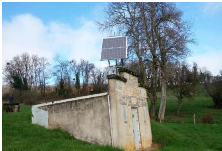
Réservoir de Mardigny
