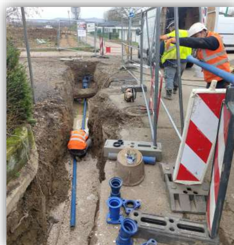
Raccordement rue des Vignes avenue des Coteaux à Marly
