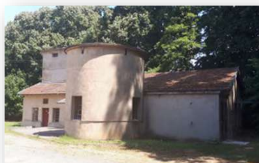
Usine de production d'eau potable de Saint Eloy
