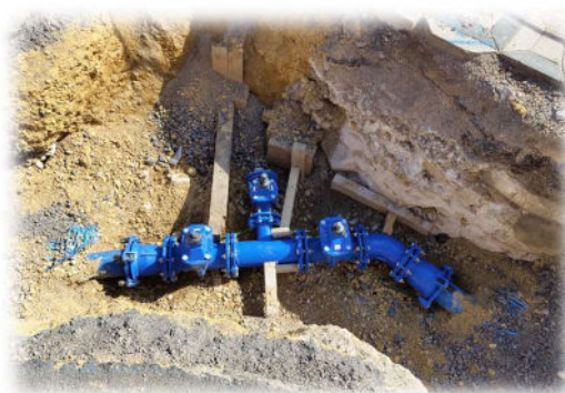
Raccordement rue de Metz à Marly
