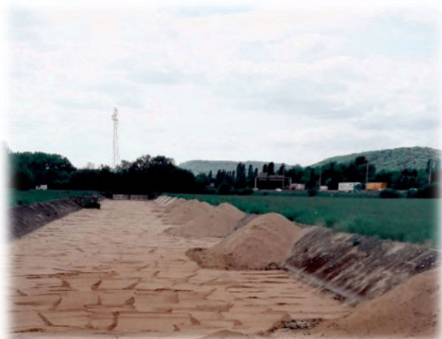
Bassin sud de Maison Rouge
