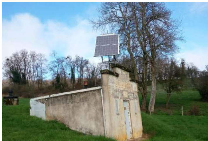
Réservoir de Mardigny
