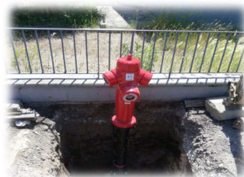
Renouvellement poteau incendie rue Albert Bosch à Montigny-lès-Metz
