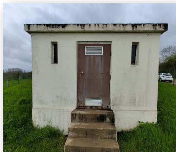
Réservoir de Marieulles
