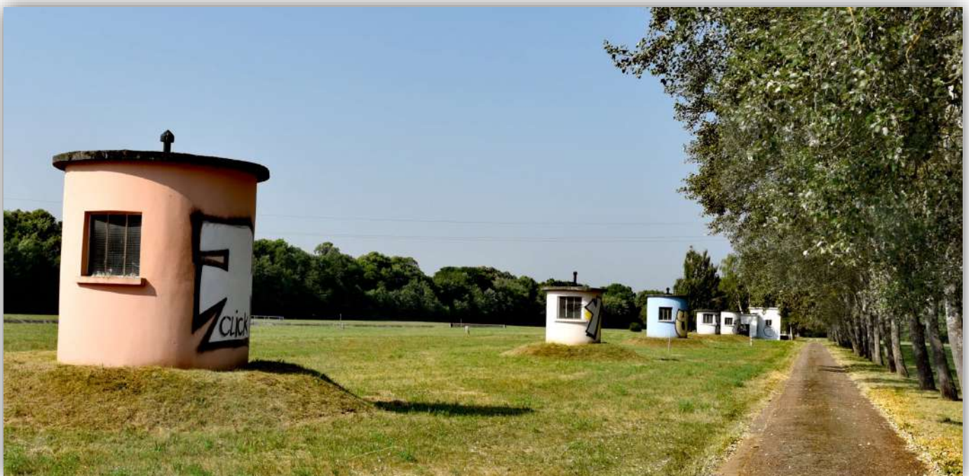
Puits - Site de Maison Rouge à Moulins-lès-Metz
